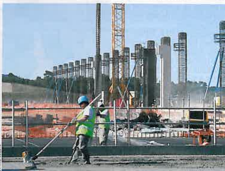
Chantier d'Iter : la dalle et les colonnes de l'immense bâtiment de fabrication des bobines toroïdales sont en cours de réalisation.
