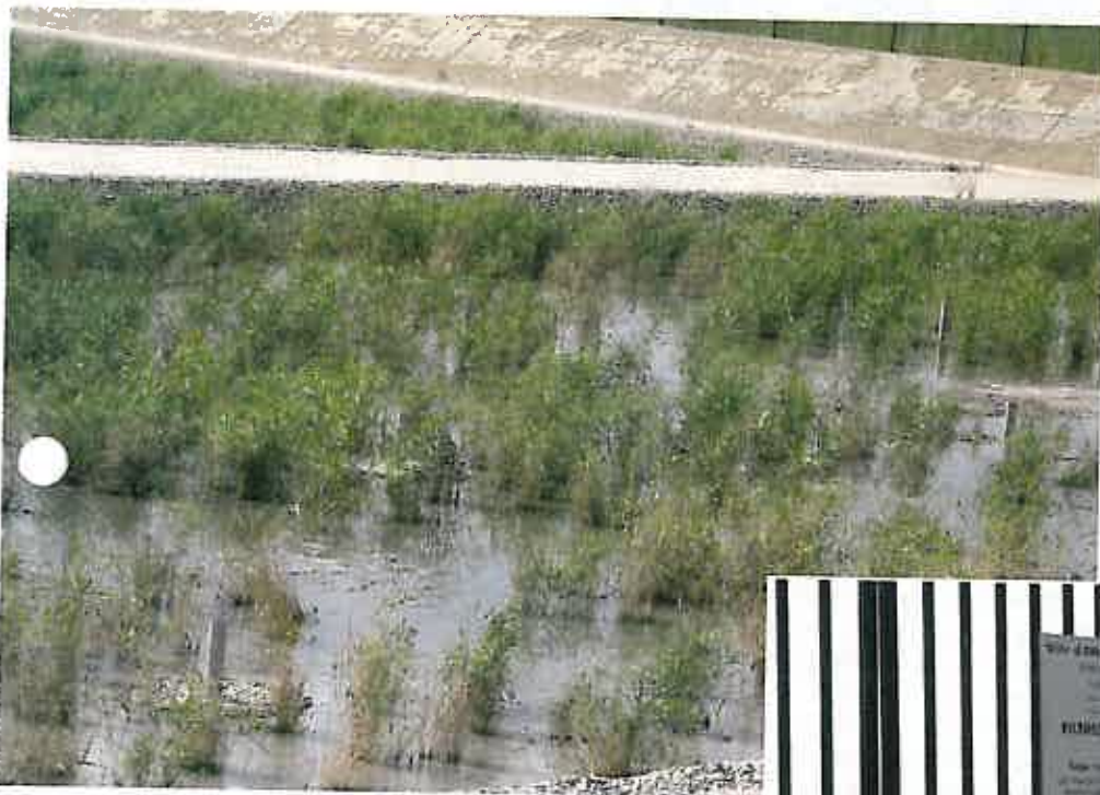
La nouvelle station d'épuration de Salins-de-Giraud (commune d'Arles) utilise la capacité d'épuration des roseaux.
