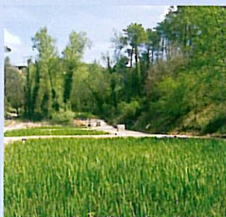
Epur Nature réalise des stations d'épuration en roseau plantée. Facilement intégrable dans le paysage, elles ne dégagent pas d'odeur et permettent de réduire les volumes des boues. En raison, de leur étendue, elles sont pour l'instant limitées à des communes de moins de 4000 habitants.
