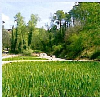
Epur Nature réalise des stations d'épuration en roseau plantée. Facilement intégrable dans le paysage, elles ne dégagent pas d'odeur et permettent de réduire les volumes des En raison, de leur étendue, elles sont pour l'instant limitées à des communes de moins de 4000 habitants.
