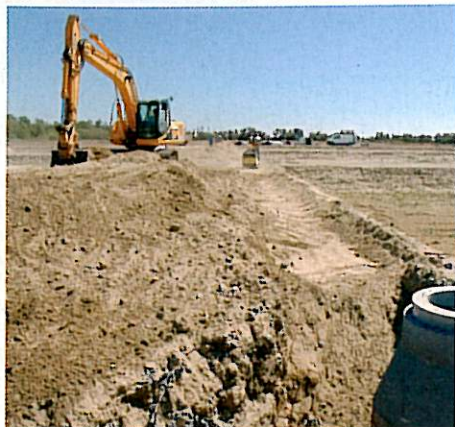
Aménagement des bassins de la station d'épuration
